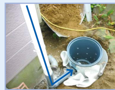
雨どいの水を水路に流さずに地面に浸透させます。
