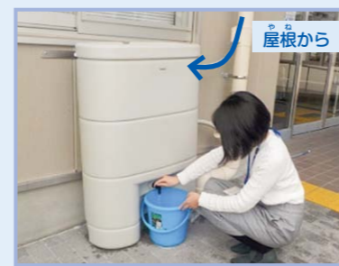
雨どいを流れる雨水がタンクに流れこみます。
