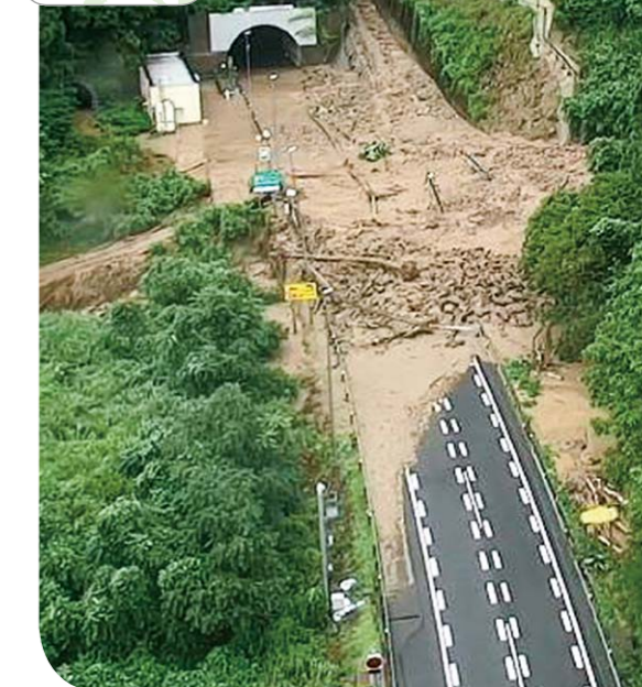
大雨の影響で土砂崩れが発生した北陸自動車道 令和4年8月5日 敦賀トンネル付近 福井県ホームページ
