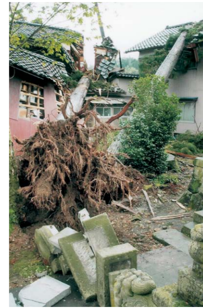
平成16年 台風23号 巨木2本が倒れ破損した民家 越前町宝泉寺 福井新聞社 提供
