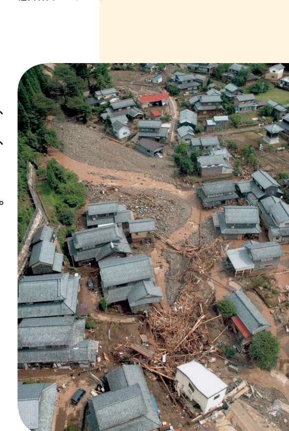
福井豪雨 土石流で破壊された民家、寸断された道路 福井市浄教寺町 福井新聞社 提供
