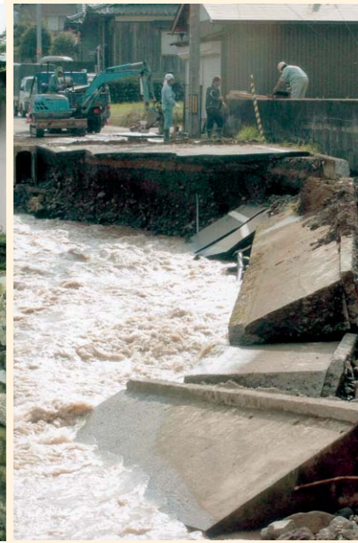
平成16年 台風23号 一乗谷川の増水で 削り取られた道路 福井市西新町 福井新聞社 提供
