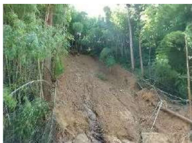
写真-3 崩壊斜面（左岸）上部の湧水
