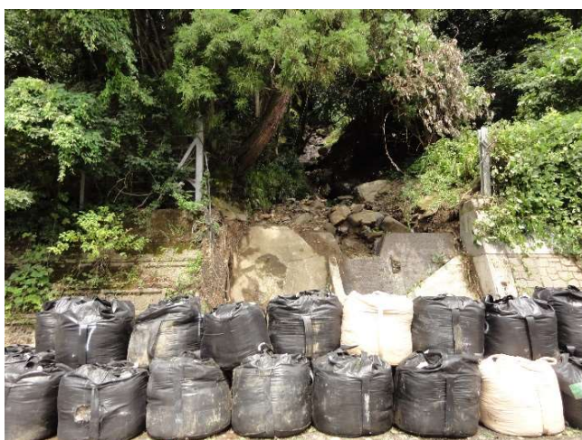
写真-7 既設の谷止め工
