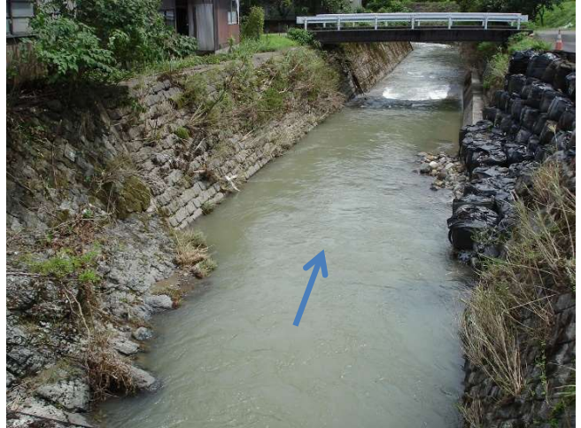
写真-2 左岸の状況
