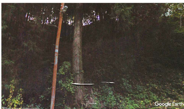
写真-13 隣接斜面の崩壊前のストリートビュー (Google Earth)
