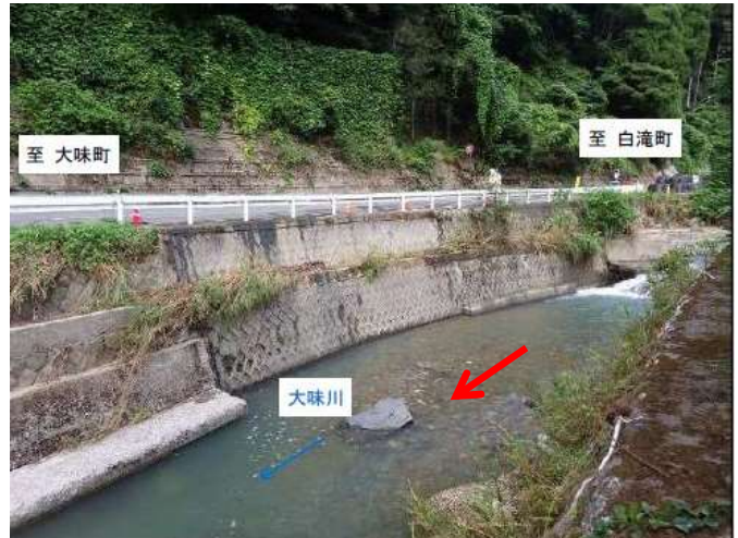
写真-4 被災直後（下流側から）
