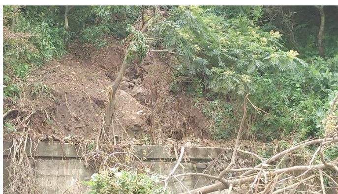
写真-14 道路際擁壁の上部
