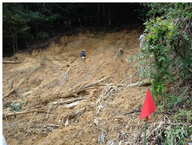
写真-8 崩壊面の露岩
