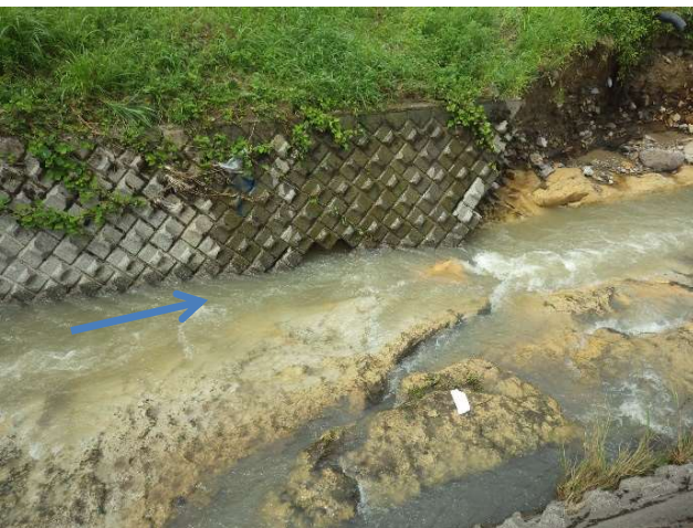
写真-5 河床の基盤岩
