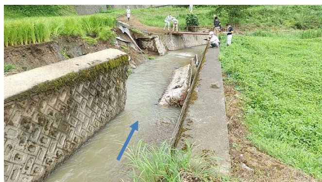
写真-8 上流側から
