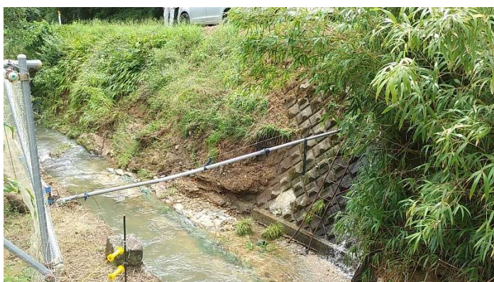
写真-9 右岸側全景
