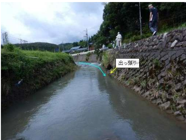
写真-2 水の流れ (下流側から)
