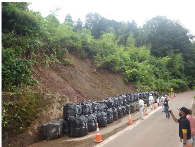
写真-4 全景（左側から）
