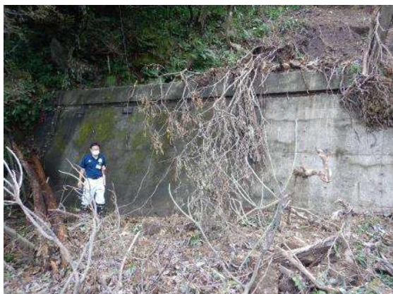
写真-9 道路際擁壁上部の擁壁
