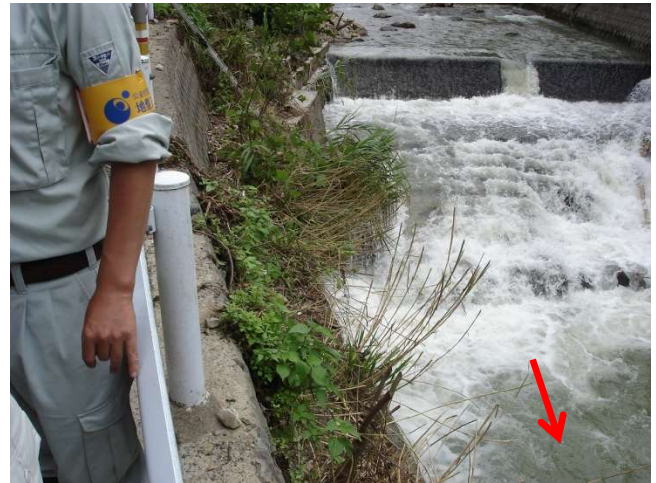
写真-12 落差工（下流側から）
