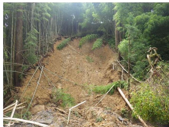
写真-4 崩壊斜面（左岸）上部
