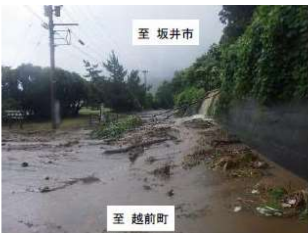
写真-1 土砂流出直後
