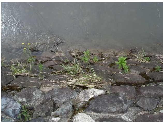
写真-4 石積みと基礎の状況
