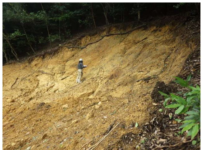
写真-6 崩壊面の露岩
