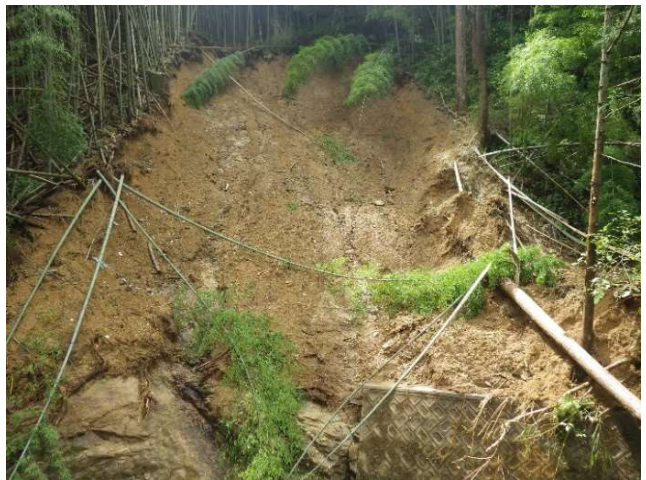
写真-8 崩壊斜面（左岸）下部
