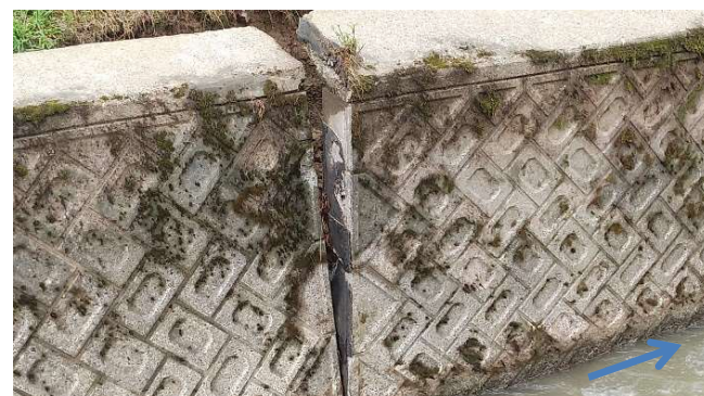
写真-10 崩壊箇所上流の護岸
