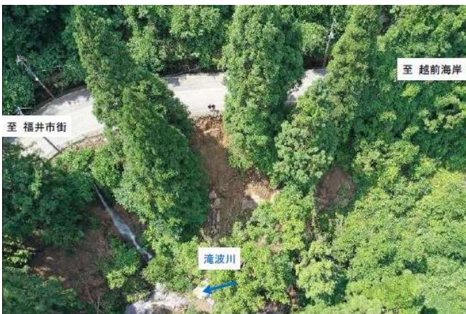
被災 No.59 路肩崩壊
