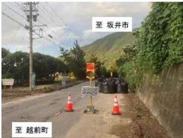
写真-4 応急復旧
