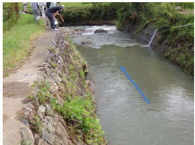
写真-3 水の流れ (上流側から)
