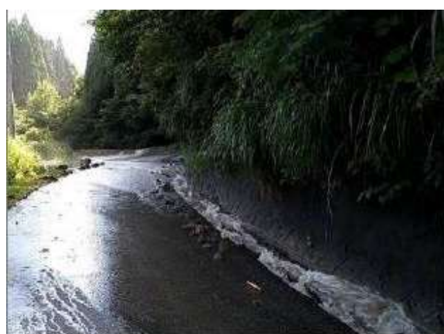
写真-8 溢水の道路部流下（災害直後，下流部から）
