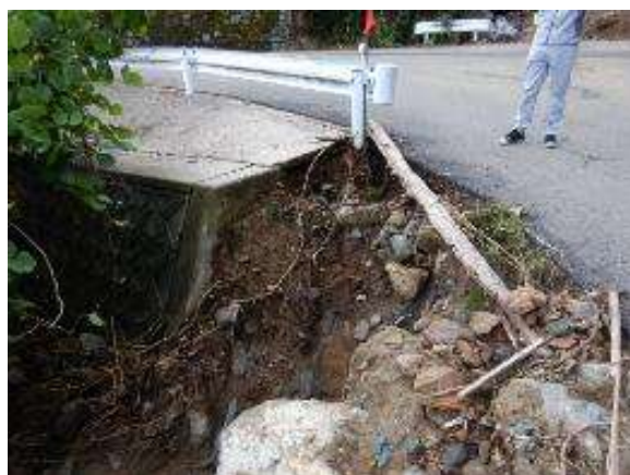
写真-6 道路横断暗渠管（下流側）
