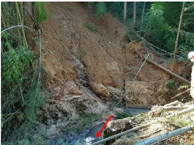
写真-7 崩壊斜面（左岸）下部
