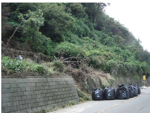
写真-13 道路際擁壁の階段工
