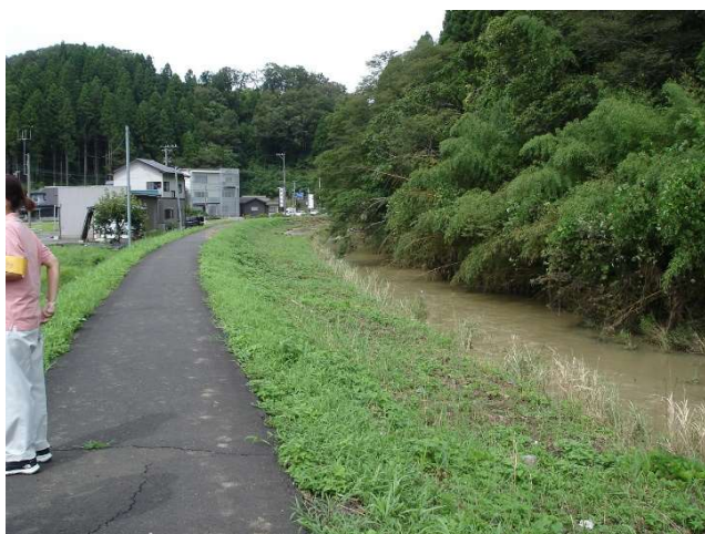
写真-4 決壊箇所下流で川幅が狭くなる
