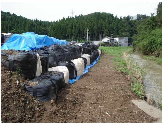
写真-11 堤外側の土のう (2段)
