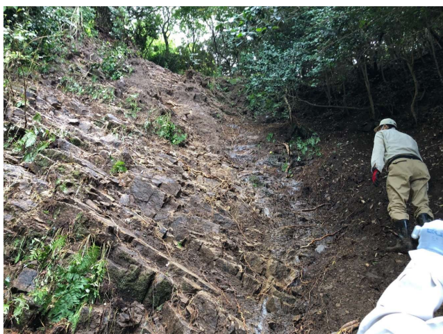
写真-5 溪流上部 (福井土木事務所)
