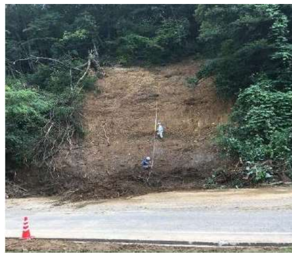
被災 No.65 自然法面崩壊
