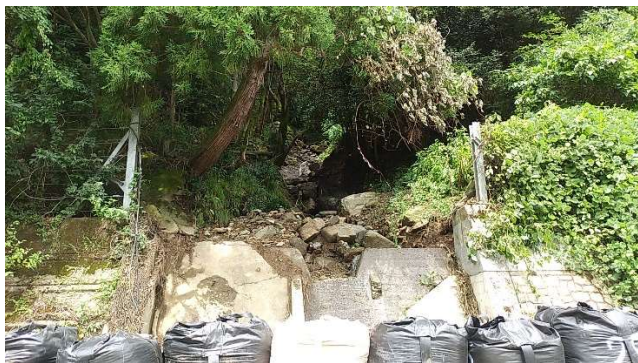
写真-5 既設の谷止め工
