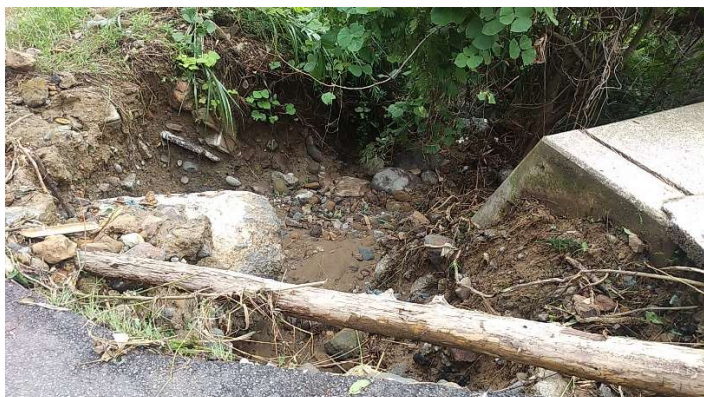
写真-5 道路横断暗渠管（下流側）
