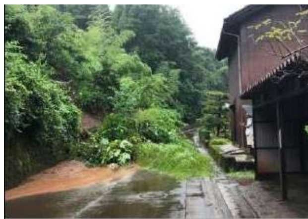
写真-2 崩壊直後
