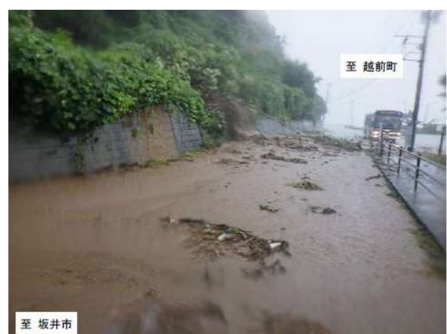
写真-2 土砂流出直後
