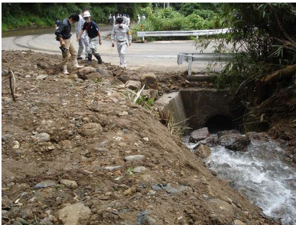
写真-1 道路横断暗渠管 (上流側)
