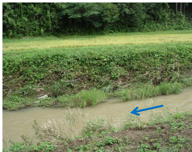
写真-5 右岸（越流なし）
