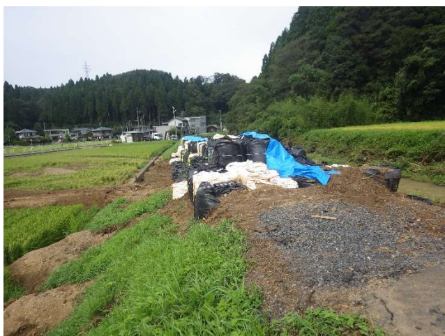
写真-12 堤内側の土のう (3段)
