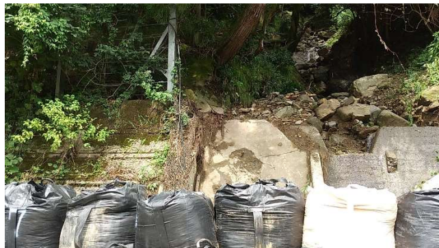
写真-6 既設の谷止め工
