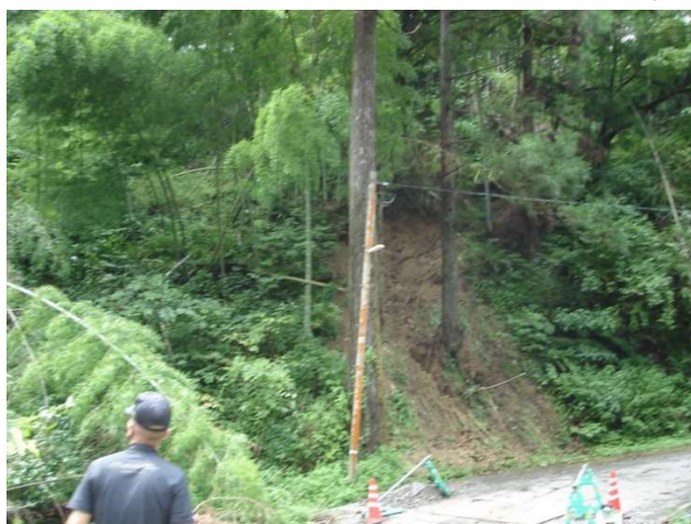
写真-15 隣接崩壊斜面
