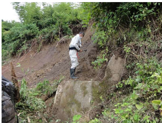
写真-5 全景（右側から）
