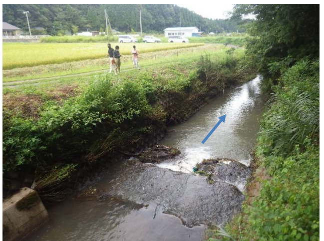
写真-4 上流部落差工
