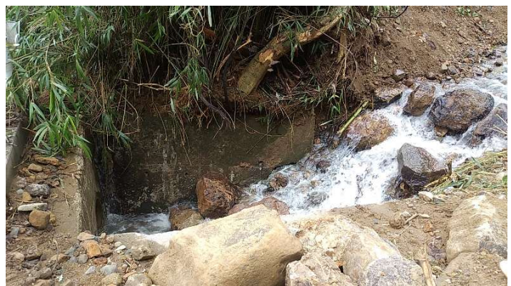
写真-4 道路横断暗渠管の上流部
