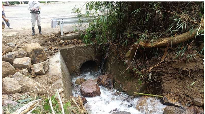
写真-2 道路横断暗渠管 (上流側)
