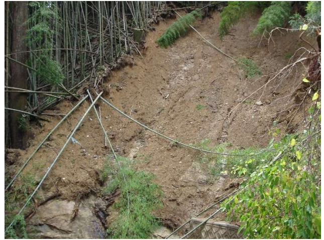
写真-6 崩壊斜面（左岸）上部
