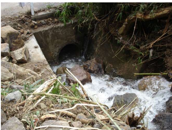
写真-3 道路横断暗渠管 (上流側)
