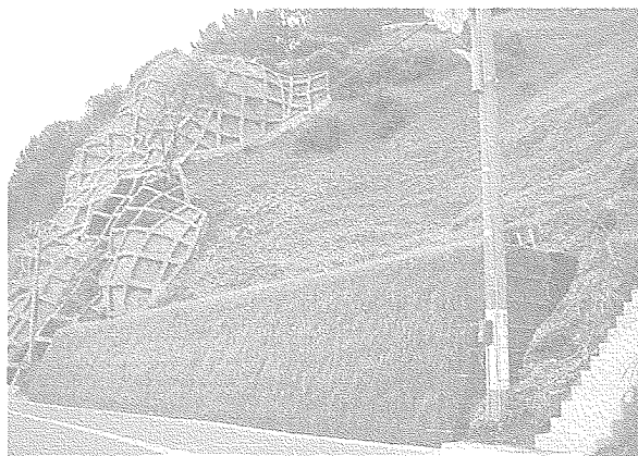
図1-1 国道305号沿いの落石対策工
