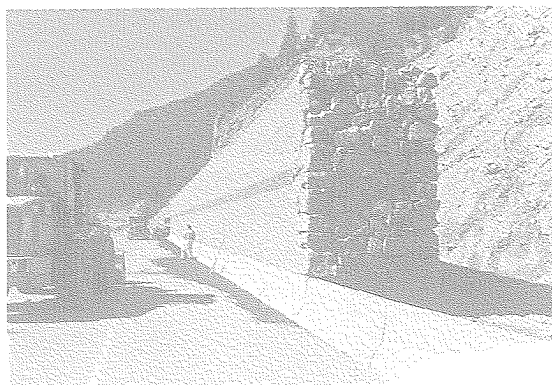
図1-4 ダイク型落石防護擁壁（コロラド州）
