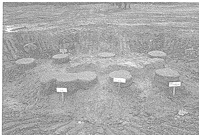
写真-5.12 FMP試験施工杭の全景
