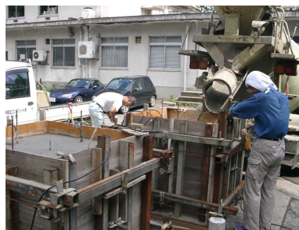
写真 11-1 コンクリートの打設状況
