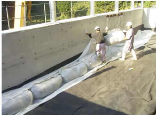
荷重分散層土のう設置状況
