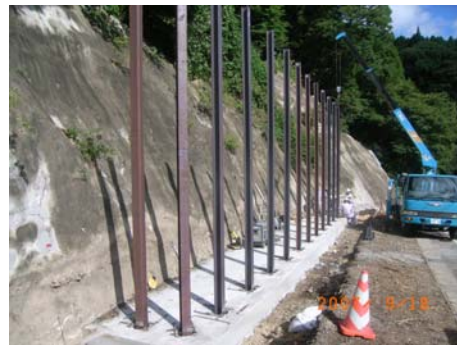
縦支柱建てこみ完了
