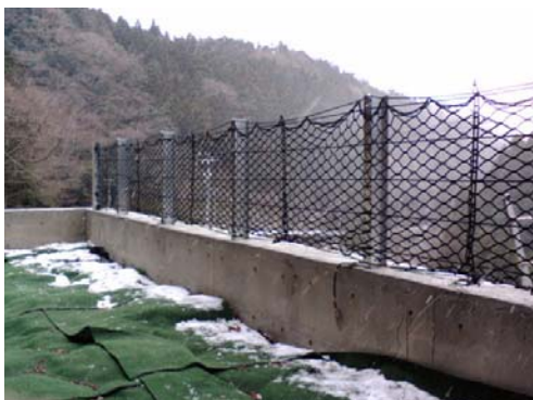
写真-5.3.10 繊維ネット設置状況
