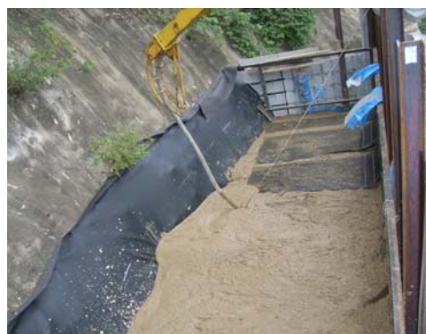
短繊維入り気泡混合土打ち込み
