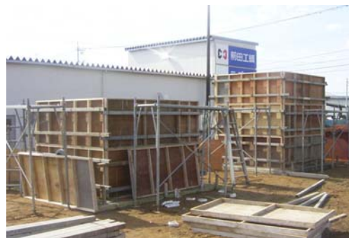
壁面材無しモデル 型枠組み立て
