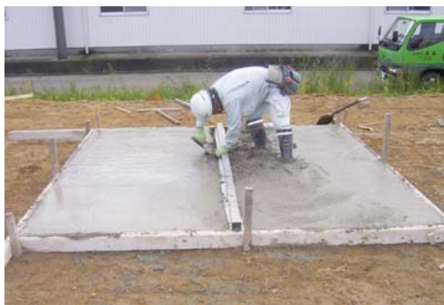
底盤均しコンクリート
