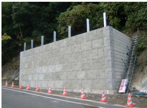
防護壁構築完了
