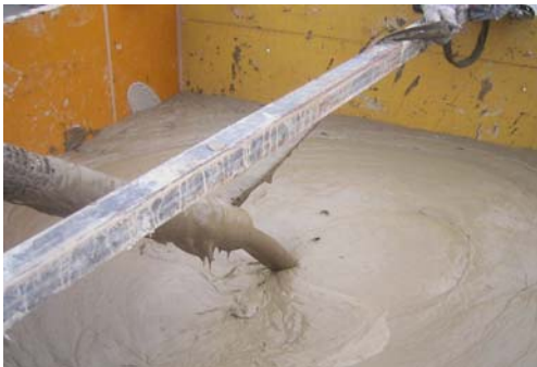
気泡混合土打ち込み状況
