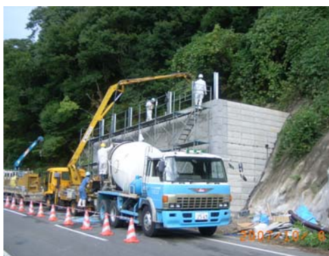
ポンプ車打設
