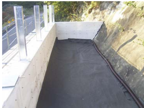
天端保護シート敷設完了
