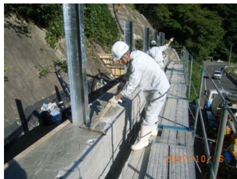
エアミルク打ち込み状況
