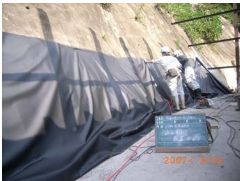
背面遮水シート設置
