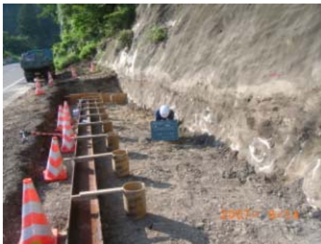
基礎型枠組み立完了
