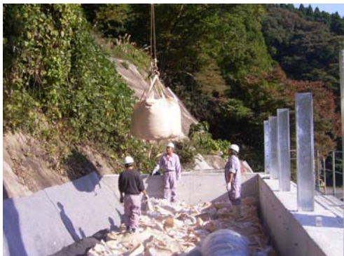
写真-5.3.9 衝撃吸収層施工状況
