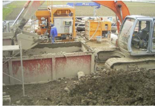
解泥作業状況
