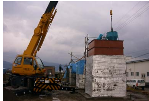
衝撃吸収層施工状況
