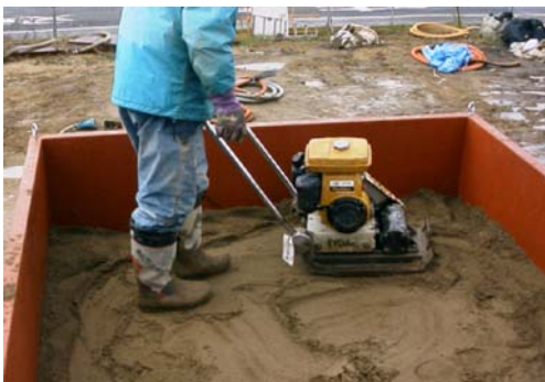
衝撃吸収層施工状況
