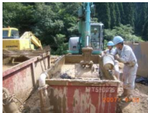
短繊維入りセメント混合土攪拌状況
