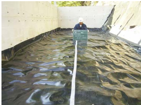
天端遮水シート敷設完了
