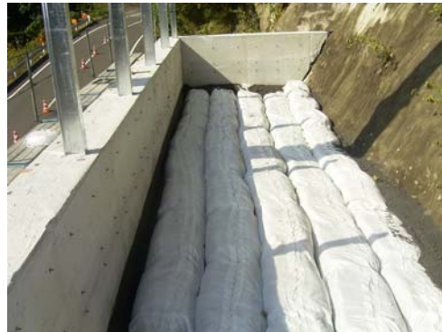
荷重分散層設置完了
