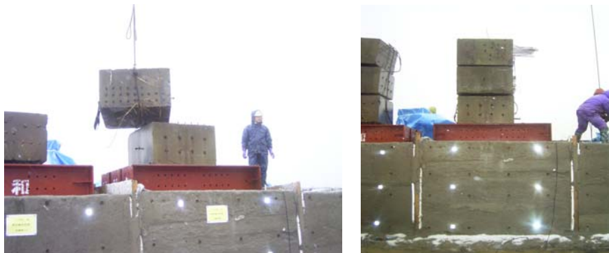
写真-2.3.2 静的載荷試験状況
