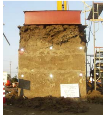
No.2 壁面無し 繊維有り
