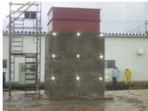
壁面変位ターゲット(壁面材無し)
