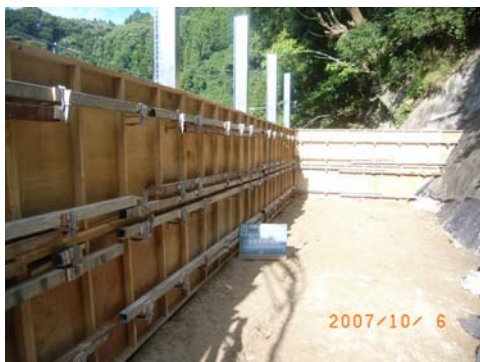
上部隔壁背面型枠組み立て完了
