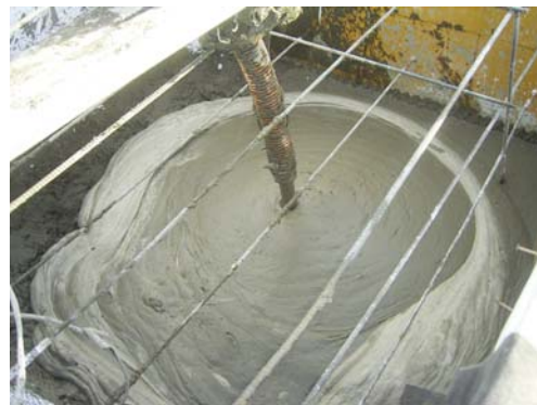
打ち込み状況
