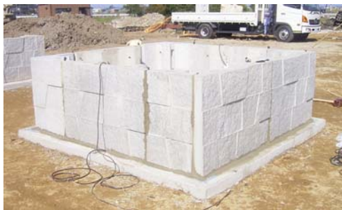
壁面材有りモデル 壁面材設置
