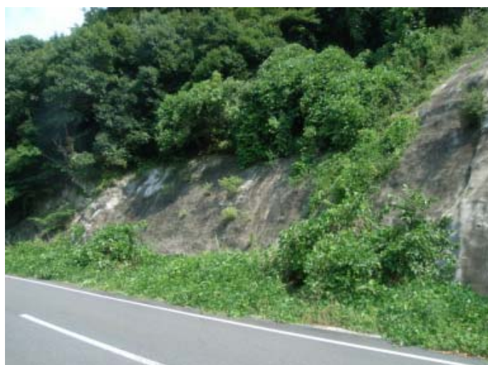
写真-5.2.1 防護壁構築前状況
