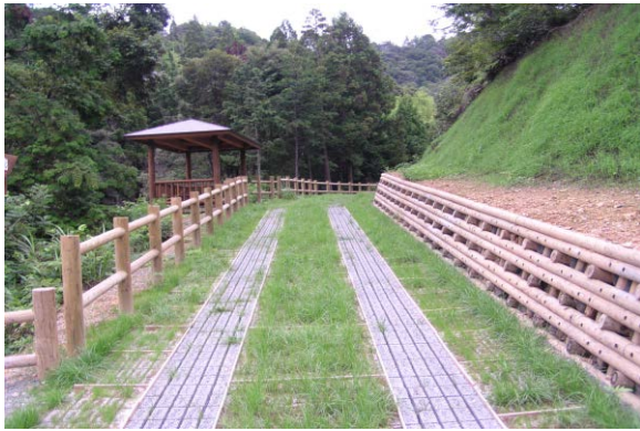
木製ブロック積工（小浜市飯盛）
