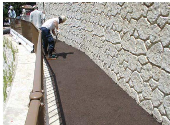
遊歩道施工状況
