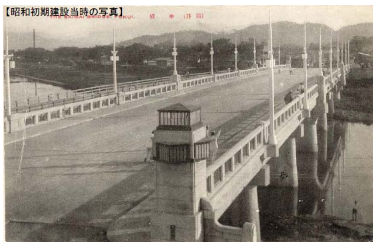
写真-6.2.5 昭和初期建設当時の幸橋 2)
