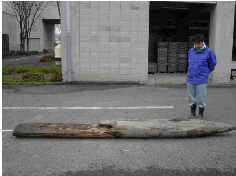
写真-6.2.7 木田橋から採取した丸太の搬入状況
