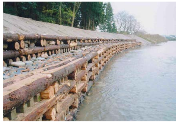
木工沈床工（福井市間山町）
