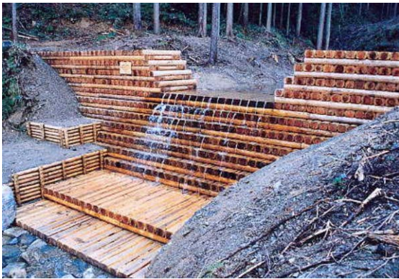
木製ダム工（大飯郡おおい町名田庄下）
