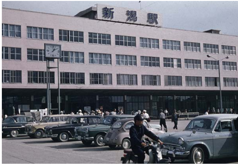
写真-5.3.1 地震後の新潟駅の様子 7) (土木学会土木図書館所蔵, 撮影: 倉西茂・高橋達夫)
