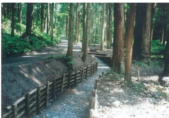
丸太水路工（越前市長五町）
