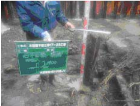
写真-1 木杭の掘出し状況
