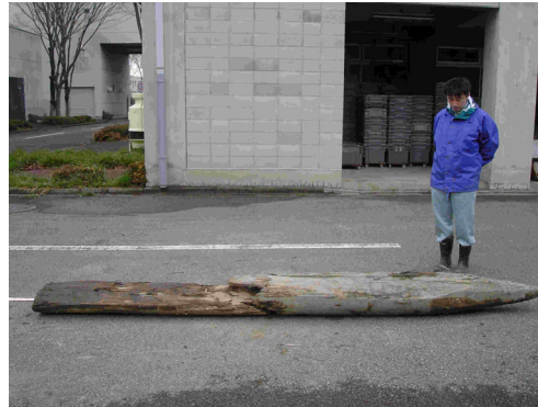
写真-2 木杭の全容
