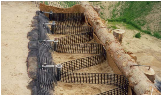
敷設実験（根回り繊維敷設状況）【H15. 4】
