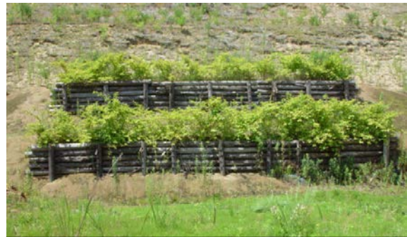
試作品の設置状況（全景）【H18.7】
