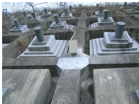
図 8.4.4 警報表示器設置状況
