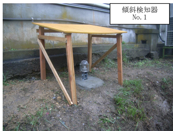
図 8.5.2 本体設置状況
