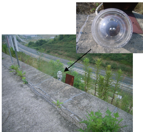
図 8.4.2 本体設置状況（上部）
