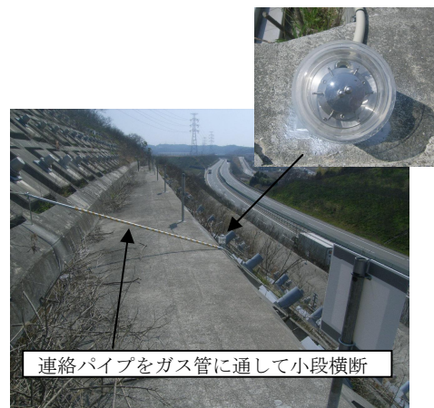
図 8.4.3 本体設置状況（下部）および連絡ホースの小段横断部
