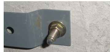
打ち込み完了のイメージ
