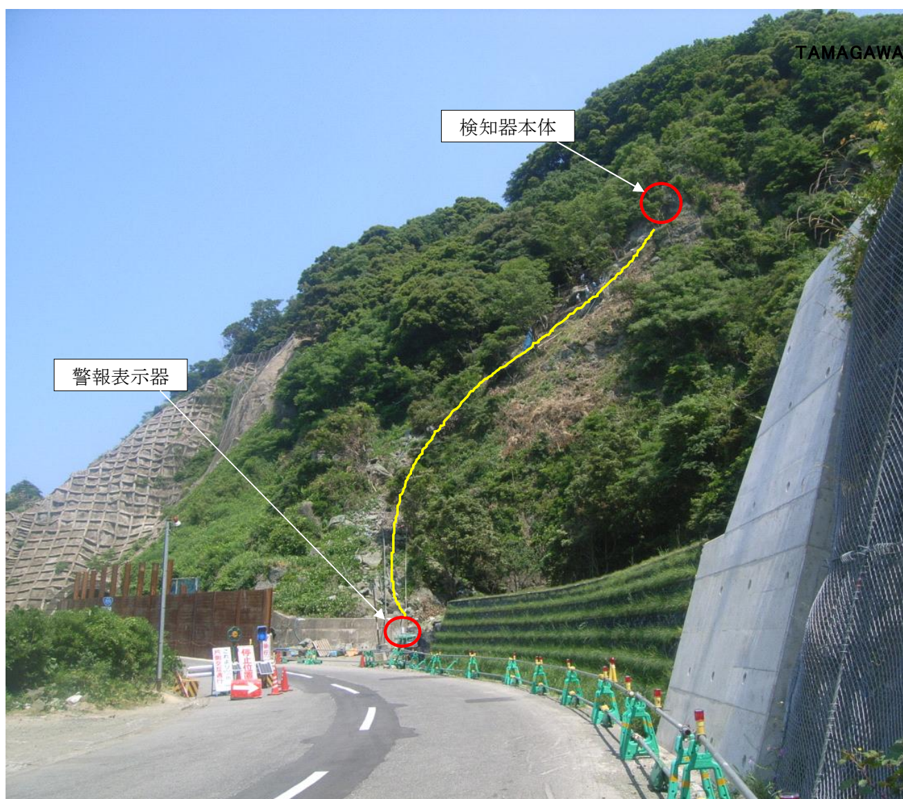
図 8.1.1 不安定岩塊の挙動監視事例箇所の全景
