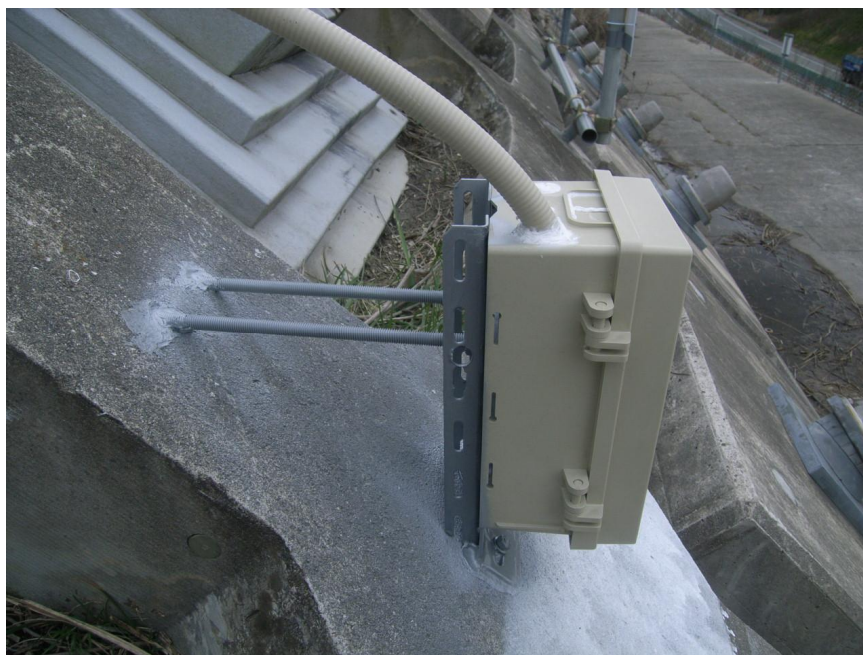
勾配の緩い箇所に警報表示器を設置した例。 長いボルトを利用して警報表示器が鉛直になるように設置している。
