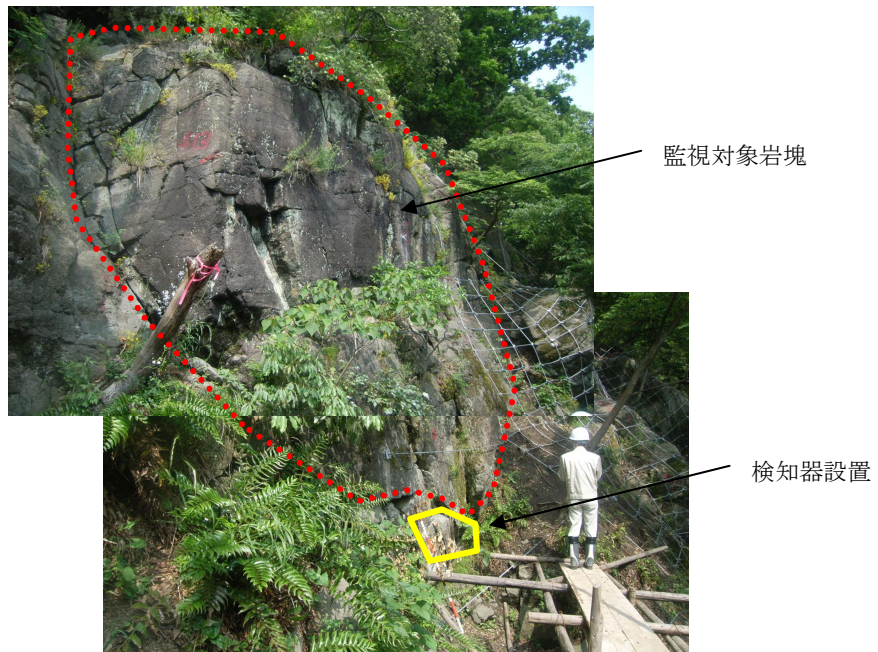
図 8.1.2 不安定岩塊の全景と検知器設置位置
