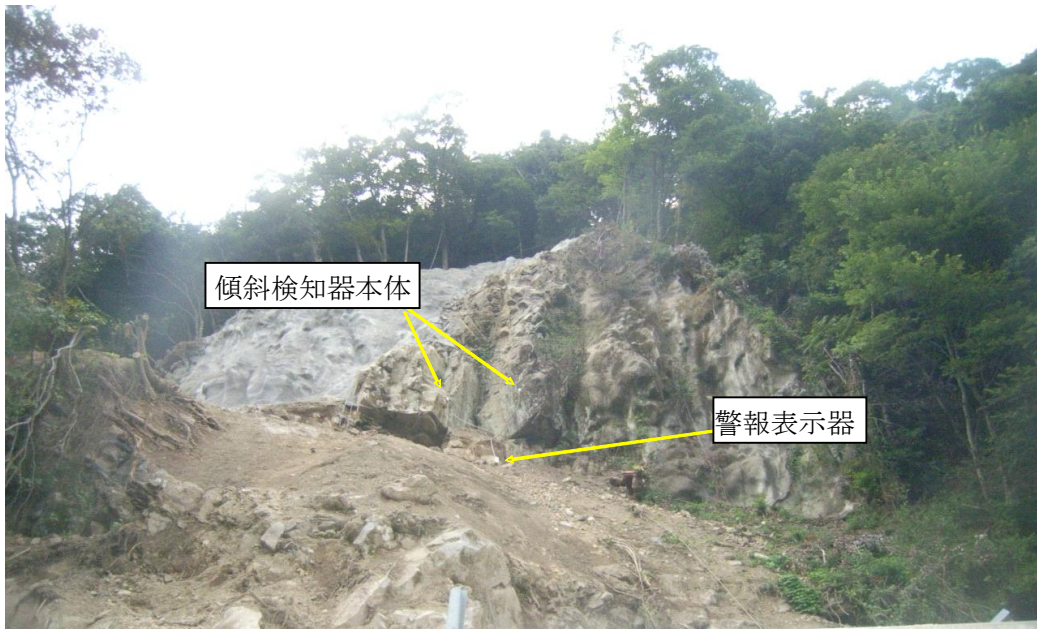
図 8.3.1 崩壊斜面の全景と検知器および警報常時器の設置位置
