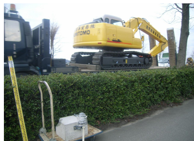
図 2.4.1 国道沿いのテスト状況
