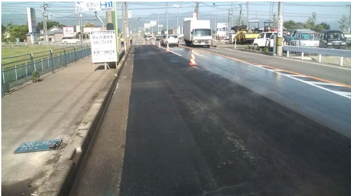
写真 5.3 転圧終了状況
