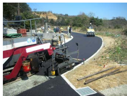
図3 木タール添加再生アスファルト舗装の施工
