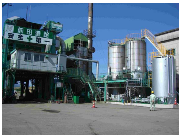
写真4.1 アスファルトプラント全景
