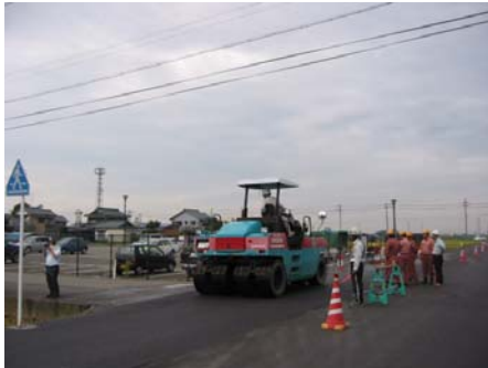
図1 施工状況（タイヤローラによる仕上げの締め固め）
