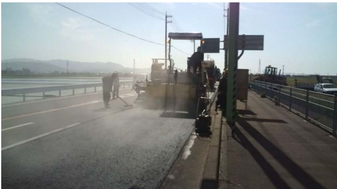
写真5.1 フィニッシャーによる敷き均し状況
