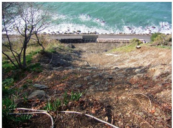
図-4.2.4 崩壊跡側壁に残存する崖錐
