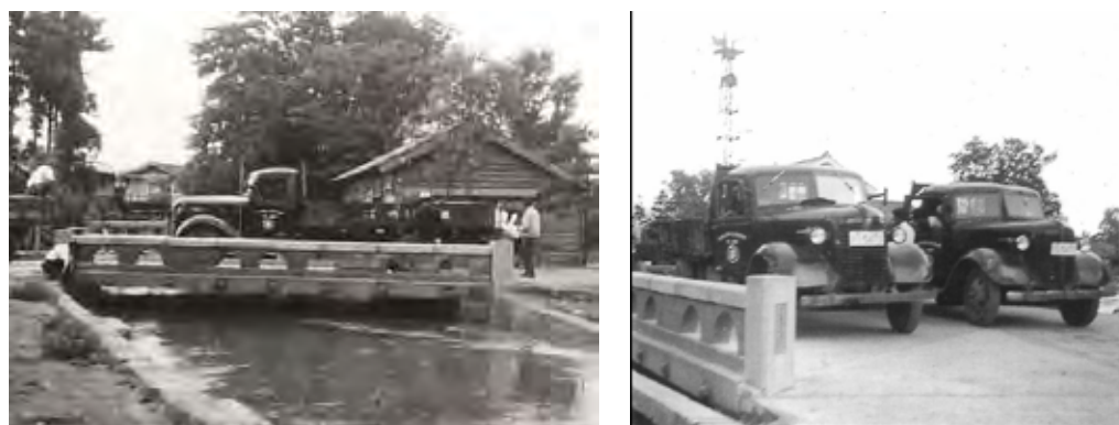
写真-4.1.8 竣工時の載荷試験状況
