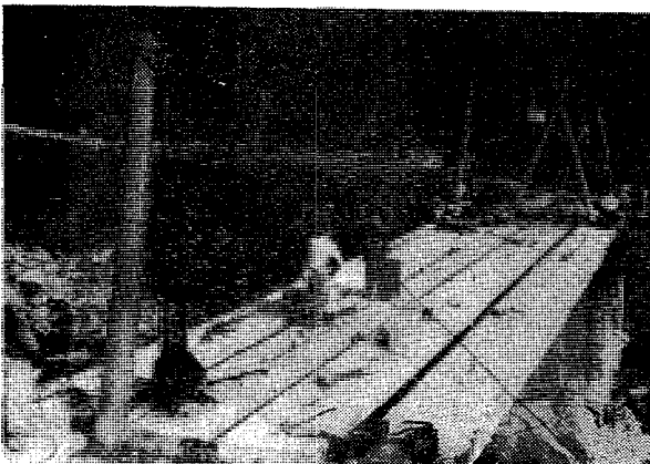
写真-10 桁架渡完了
