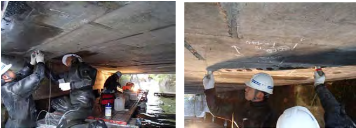
写真-5.1.3 表面法（土研法）による超音波伝搬速度測定状況
