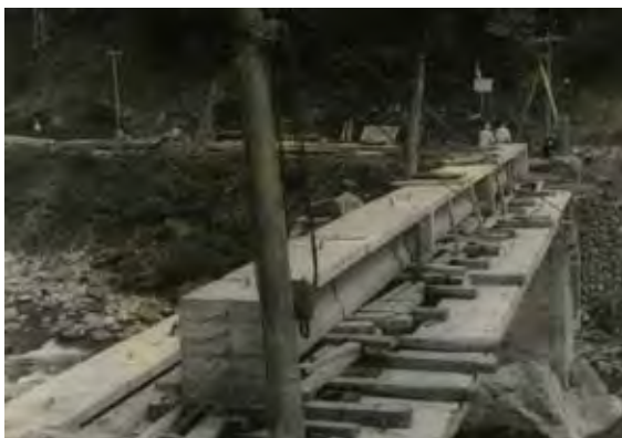
写真-4.2.5 T桁接合状況
