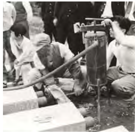
写真-4.1.5 グラウト状況
