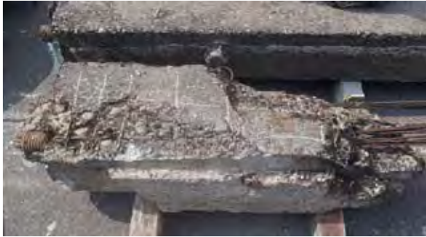
石徹白橋橋桁片 解体前状況
