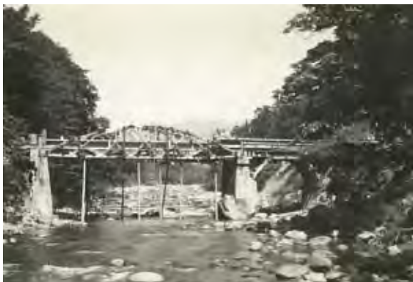
写真-4.2.4 石徹白橋の建設状況
