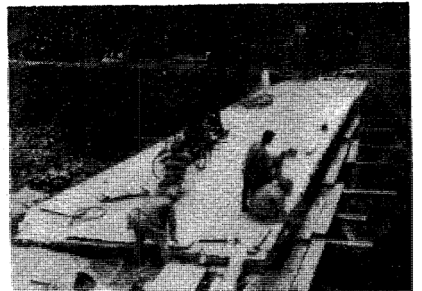
写真-12 桁間コンクリート打ち完了
