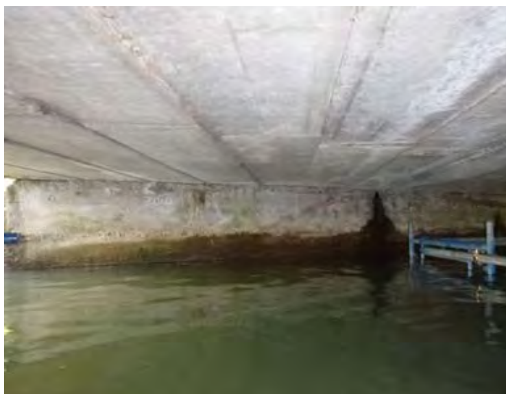
写真-6.1.1 十郷橋の桁下状況
