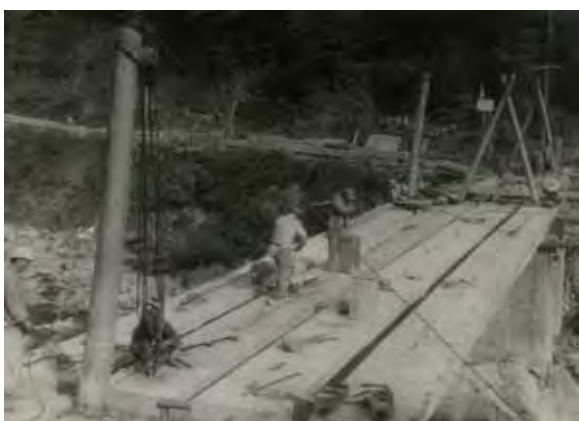
写真-4.2.6 T桁架設状況
