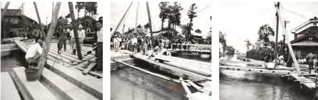
写真-4.1.6 主桁架設状況
