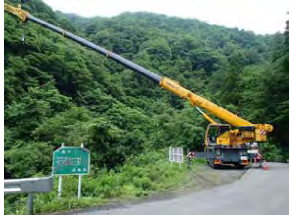
主桁の切り離し状況
