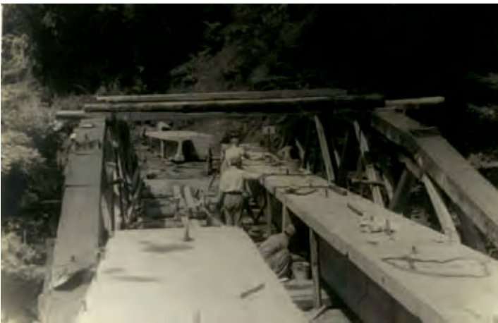
写真-4.2.2 T桁の接合状況
