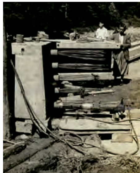
写真-4.2.3 緊張状況
