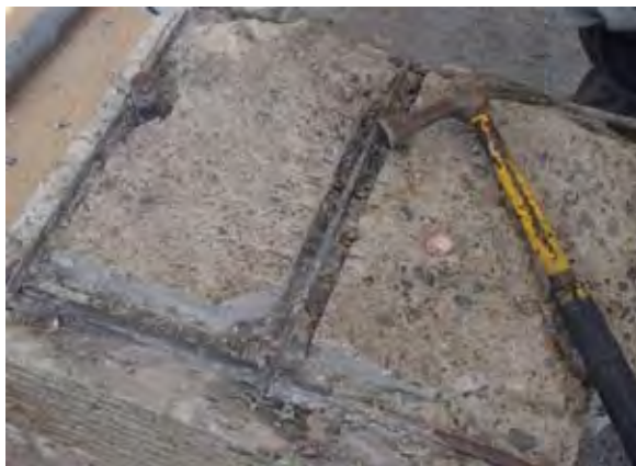
写真-5.2.9 鉄筋試験体採取状況
