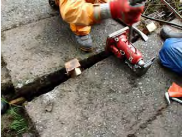
主桁の切り離し状況
