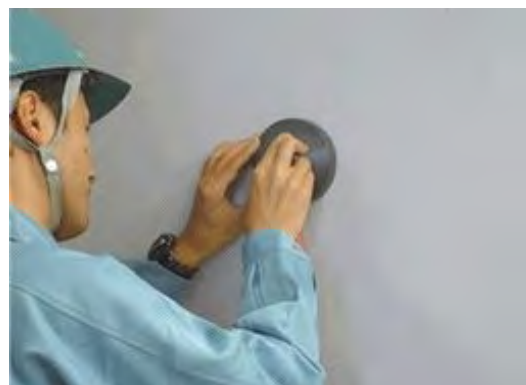
写真-5.1.5 チャンバー設置状況
