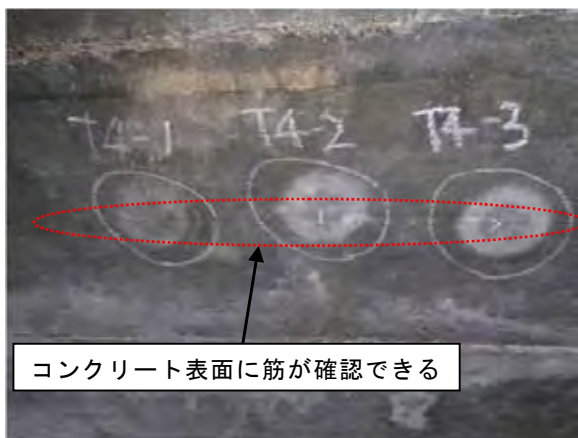
写真-6.7.2 測点T4の状況
