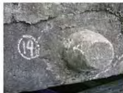
⑭横締め定着具の一部露出
