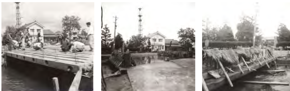
写真-4.1.7 コンクリート打設および養生状況
