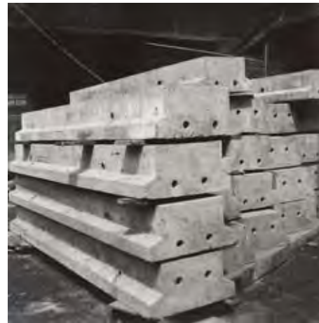
写真-4.1.2 セグメント桁
