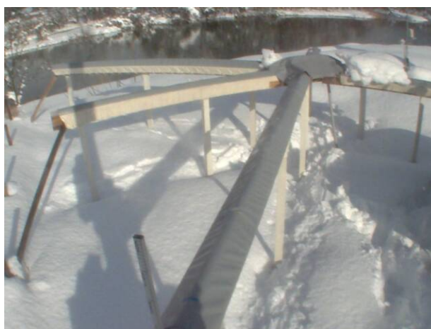
図 95 遠方手動運転による落雪試験の様子（2017年2月12日 15:25）
