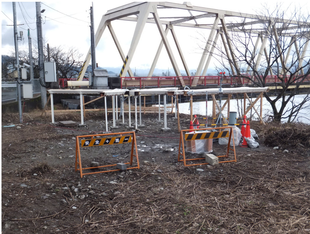
図 41 落雪試験現場状況②
