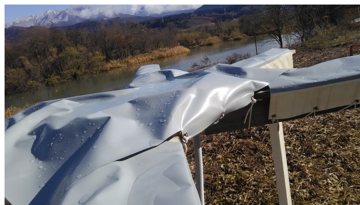
図 70 中央部の落雪装置外観
