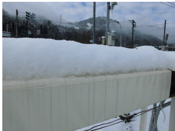
図52 積雪状況 (2016年1月15日、近景、No.1部材)
