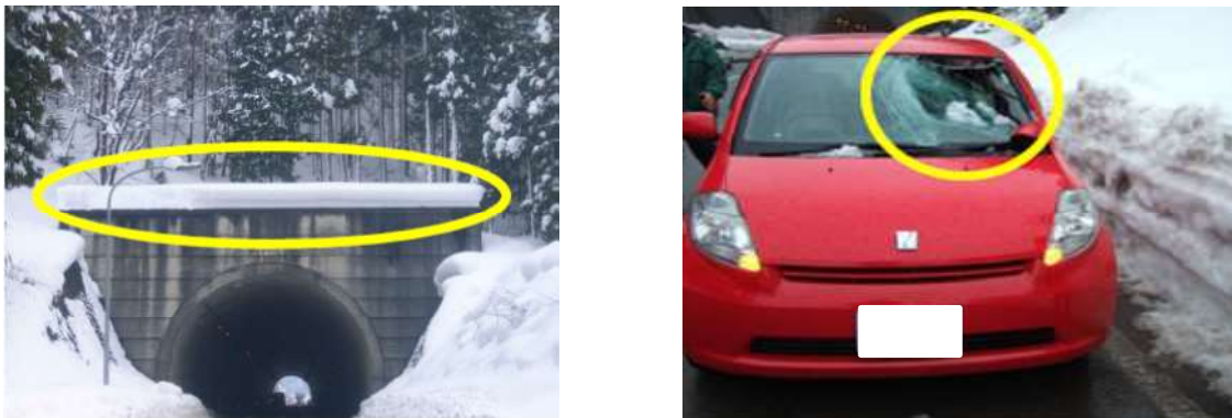
図 9 トンネル坑口上部の着雪状況とその落雪による事故状況
