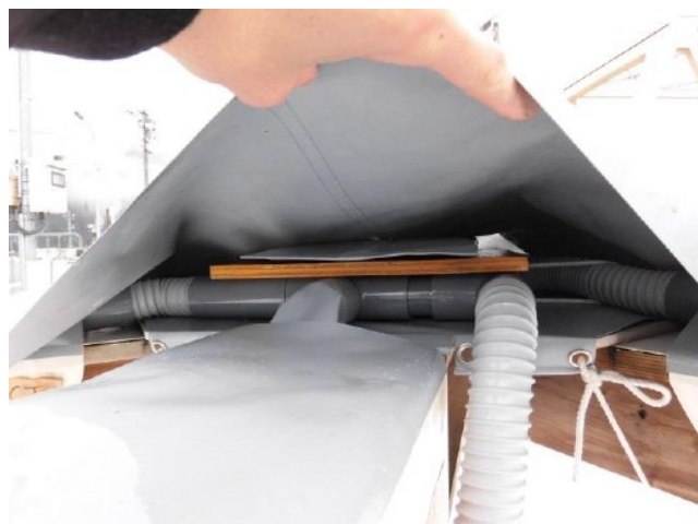
図 73 改良した中央部の落雪装置内部（コの字配管+板）
