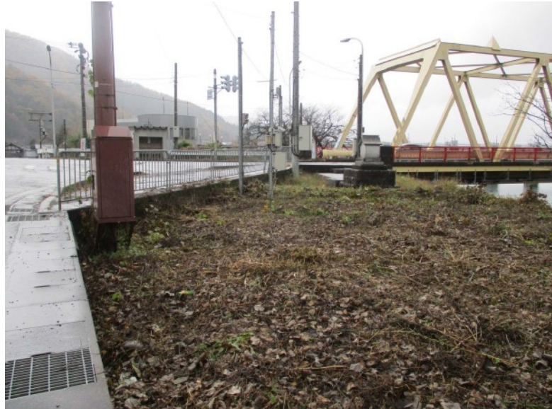
図 24 現場状況(2015 年 11 月 26 日)
