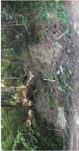
P-1 崩壊斜面 全景 護岸擁壁(高さ1.4m)に薬材が認められなかったため、擁壁の天端付近がすべり面と考えられる。
