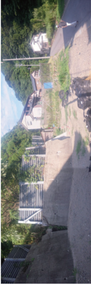
P-3 測点 No.1 付近の Aブロックから Bブロックと Cブロックを眺める。AとBブロックの継ぎ目付近に約 9 cm程度の隙間を生じている。
