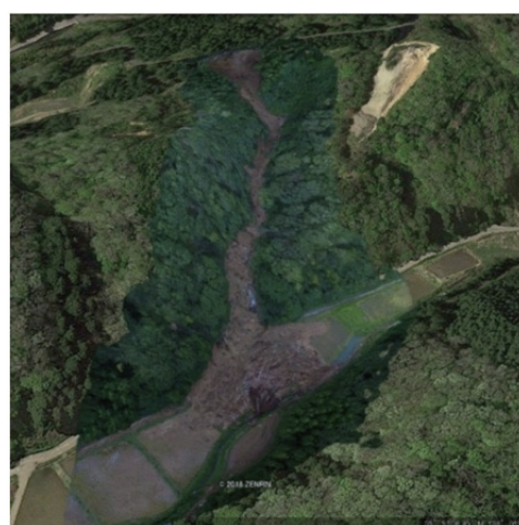
(B) 土石流発生後の地形
