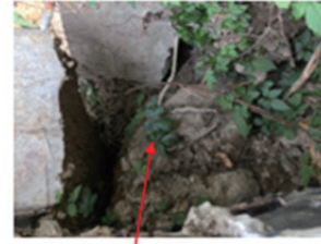
P-8 (測点 No.2とNo.3間の境界付近で隙間を生じ、基礎底面の土砂が流出している)
