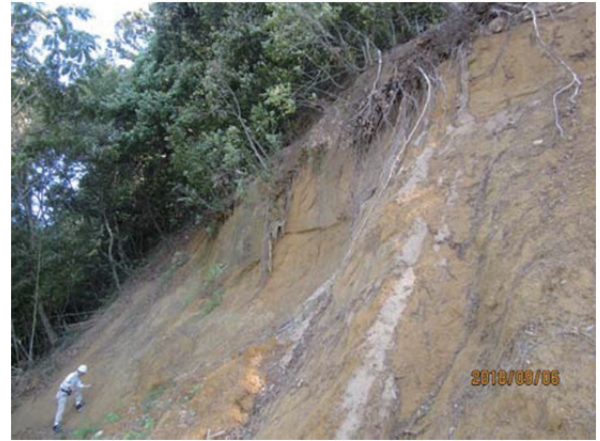
P2 崩壊斜面側面から
