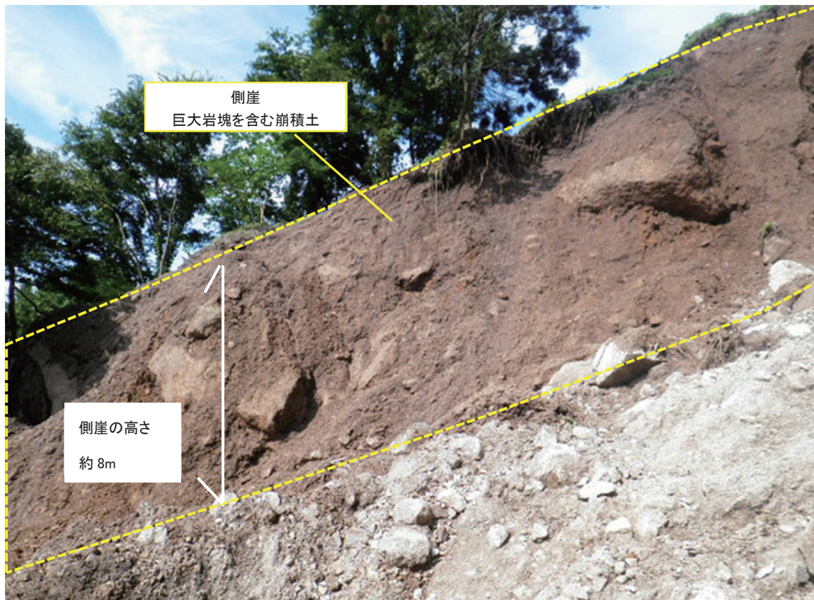
図-3.1.4 崩壊跡の側崖に認められる巨大岩塊混じり崩積土
