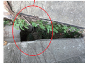
P-8 (測点 No.2とNo.3間の境界付近で隙間を生じ、基礎底面の土砂が流出している)
