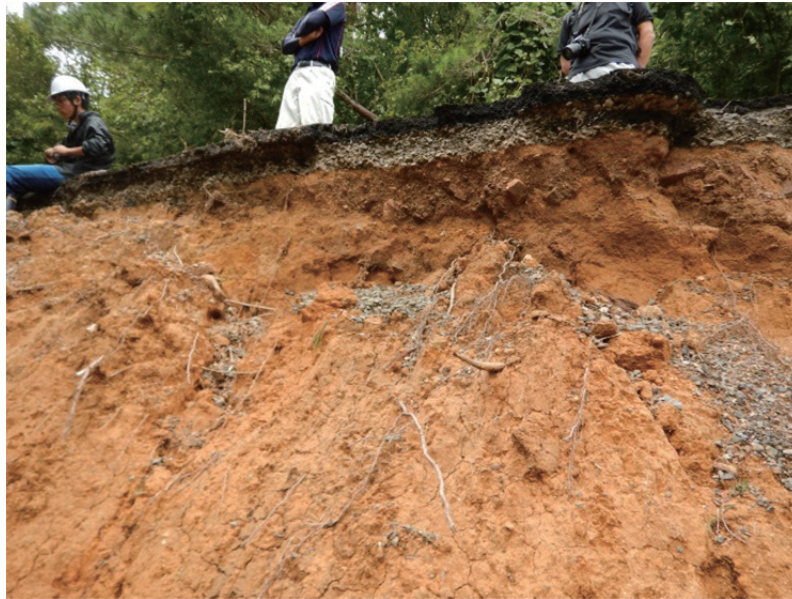
図-3.6.7 崩壊頭部の滑落崖
