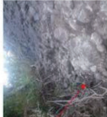
P-23 崩壊頭部の上方斜面状況 礫含有率が高く、径 50~300mm の玉石および亜円礫を多く含む。流水跡がみられる。
