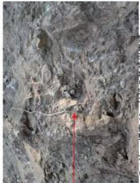
P-10' 標高 60m付近の基盤岩露頭 礫岩の風化岩で、礫の含有率が高い。 高角度の潜在的な亀裂を有する。 (丹南土木の貸与資料から抜粋)
