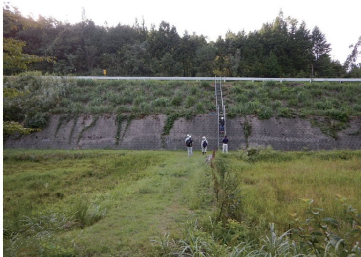
図-4.2.6 ブロック積擁壁全景
