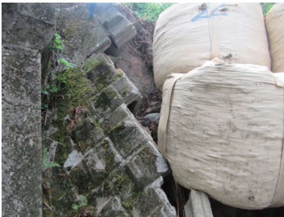
(c) 橋台とのすり付け部
