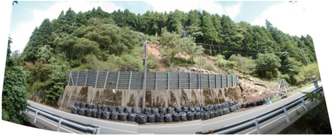
図-3.3.2 崩壊箇所の全景
