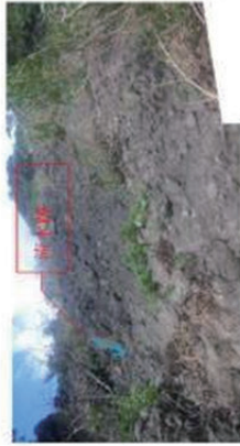
P-20 崩壊斜面 B 中央から左側面全景 平均斜面勾配 42° で、崩壊斜面には崩積土濃く分布している。崩積土が左側面から中央付近に向かってすべりを生じている。
