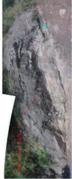
P-28 道路沿いの礫岩と砂岩の露岩 礫岩層は層厚 5m 以上で、その下位に礫混じり凝灰質砂岩が層厚 2m で分布する。地層境界は明瞭で、走向は北 27° 西で、傾斜は 22° 西落ちである。地層境界付近から地下水がしみ出ている。
