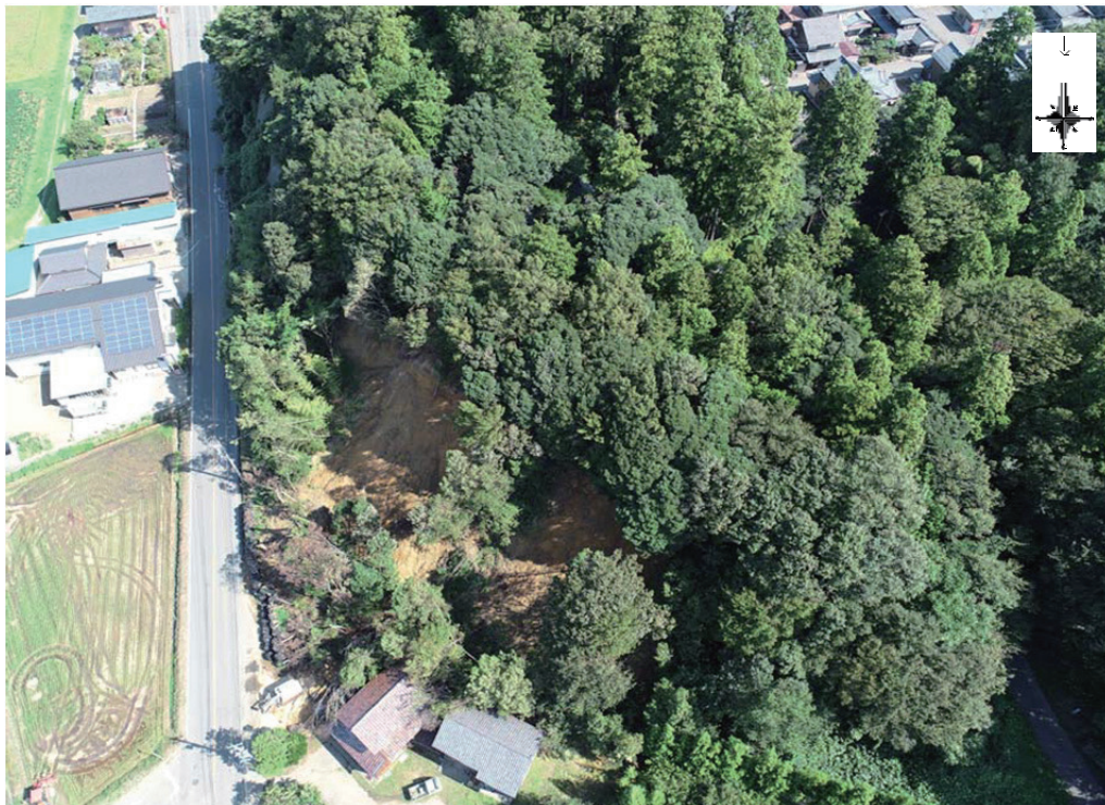
写真-3.5.1 災害箇所 (UAV 空撮写真)
