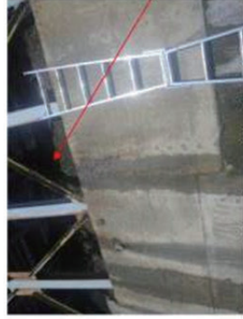
P-8 ロックキーパーの天端下からの地下水の浸みだし ロックキーパーの下の擁壁の排水管付近から地下水がしみだし ている。
