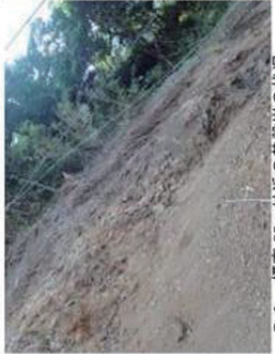
P-9 標高 55m付近の基盤岩の状況 礫岩の風化岩が分布する。斜面勾 配は42°前後で表層に1m程度の 不安定土砂が分布する。 (丹南土木の貸与資料から抜粋)
