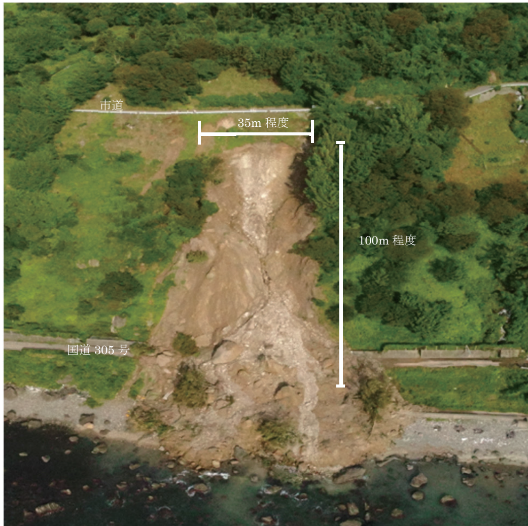
図-3.1.2 崩壊個所の空中写真
