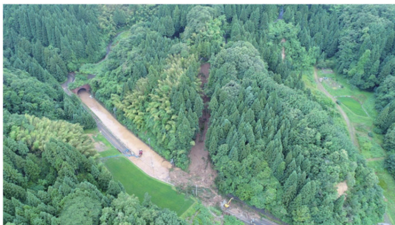
図-3.4.1 崩壊箇所の空撮写真
