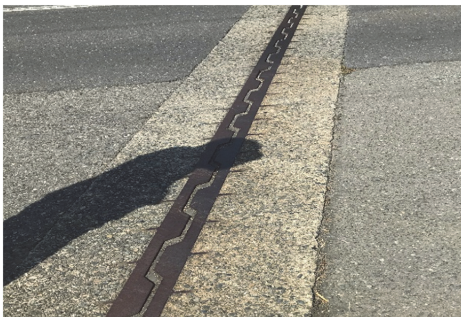
図 27 荷重支持型伸縮装置
