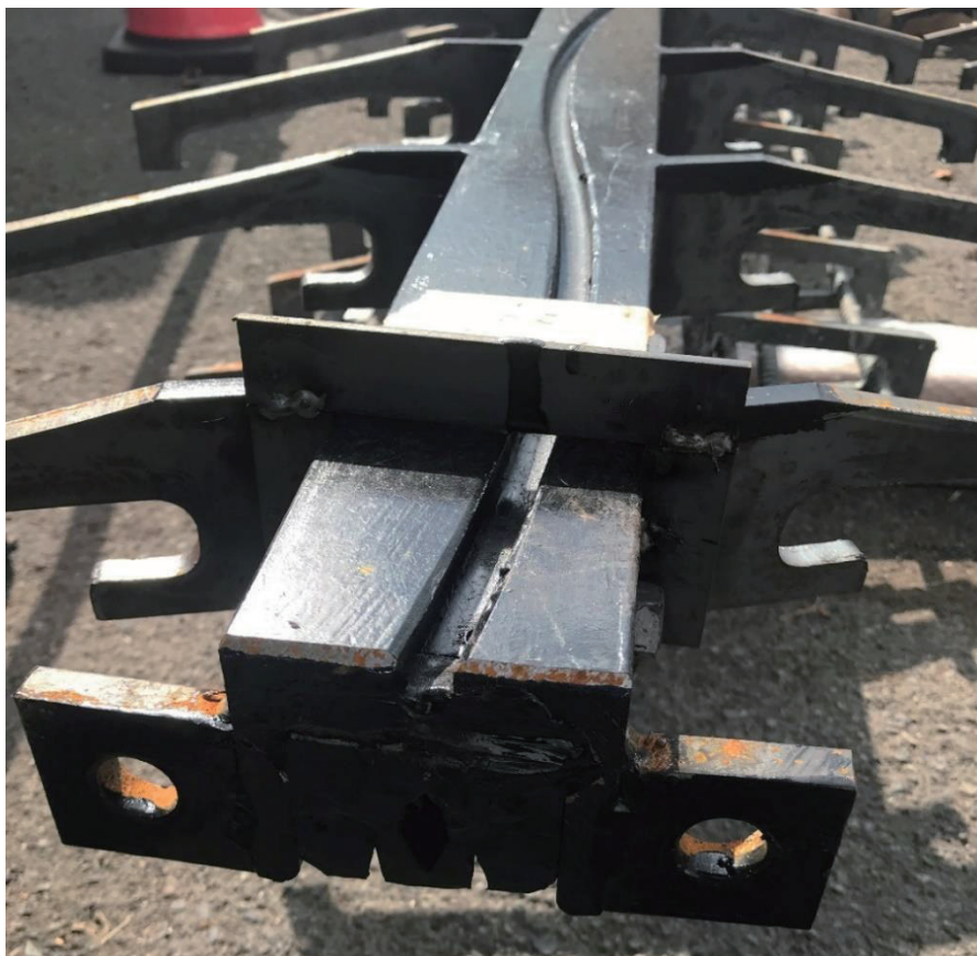
図 29 健全な伸縮装置
