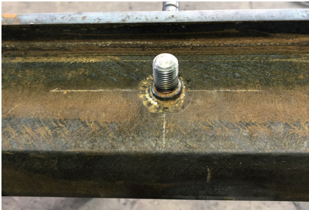
図 39 スタッド溶接で発生する突起物
