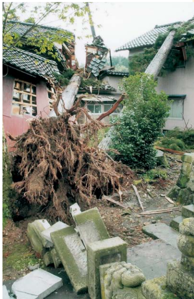
平成16年 台風23号 巨大2本が倒れ破損した民家 越前町宝泉寺 福井新聞社 提供
