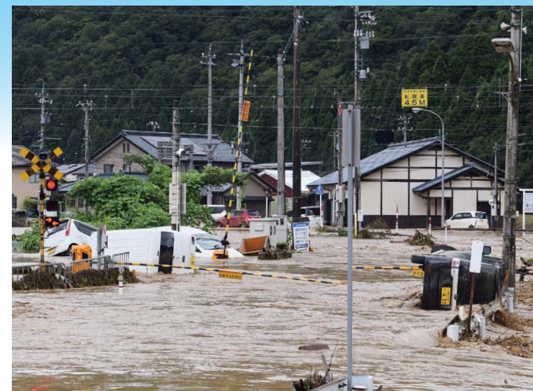
鹿森川の氾濫で水没したJR北陸線（現在 ハピラインふくい線）踏切 令和4年8月5日 南越前町今庄 福井新聞社 提供
